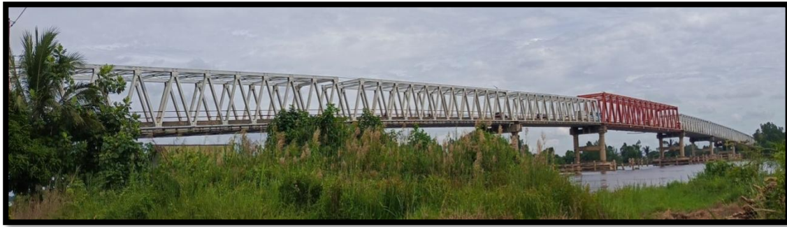
Gambar 1. Jembatan Pulau Petak Salah Satu Akses Jalan Darat Yang Ada Di Kabupaten Kapuas (Sumber: Dokumentasi Pribadi, 2024)
